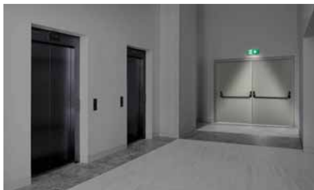
Na ausência de rede (emergência) Painel iluminado com 250lm LEDs adicionais acesos
